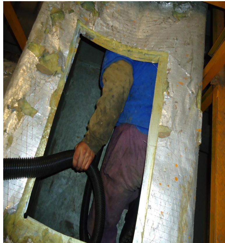
PERSONAL EN EL INTERIOR DEL DUCTO.
